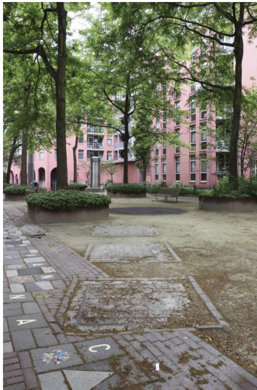
Onder de drie luiken bevinden zich de lucht inlaten van de Metro schuilplaats.
