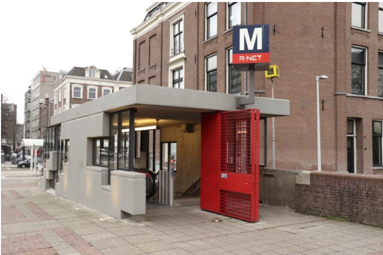
Ingang Metrostation hoek Wibautstraat en Weesperplein.
