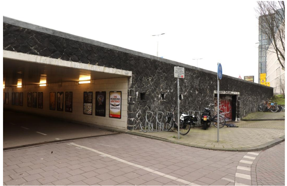
Ingang van de Schuilplaats bevindt zich achter het tegelwerk in fietstunnel.
