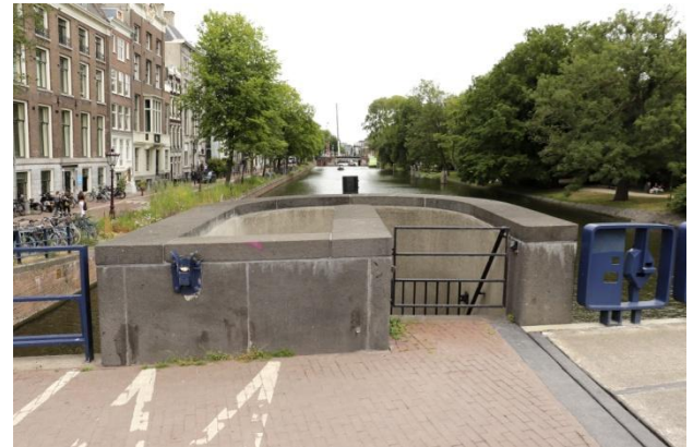
In de twee brughoofden bevinden zich de trappen die naar de schuilplaats gaan.
