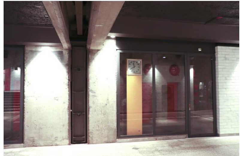
Sluis en schuifdeur om de gang af te sluiten.
